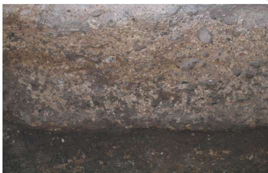
Lám I.- Detalle de la fábrica de encofrado de la muralla. Puede apreciarse el tránsito de un cajón a otro.
