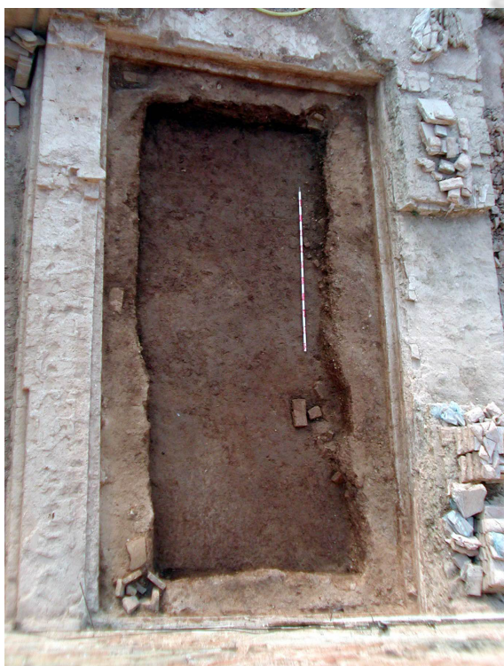
Lámina VI. Seguimiento 6. Cimentaciones y zanja de cimentación de la sala de conexión entre la galería este del claustro principal y la galería oeste del claustro de Levante.
