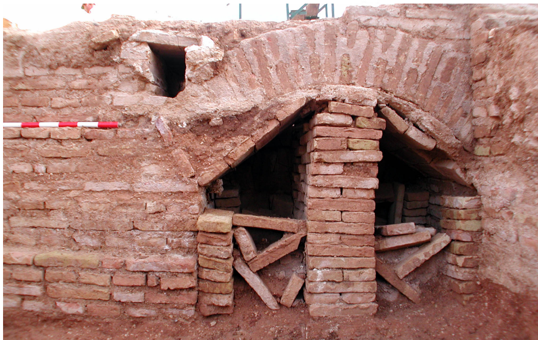
Lámina V. Corte 3. Vista frontal de la cimentación del claustro de Levante, construido a principios del siglo XVI, en la cual se inserta un arco de ladrillos de un posible respiradero que nunca llegó a ser habilitado, como prueba el hecho de que el formero de ladrillos utilizado para su construcción no fue retirado en ningún momento.
