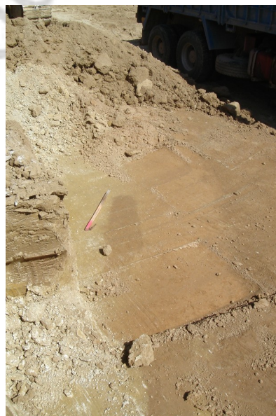
Figura 4. Zona de diferente coloración por oxidación natural de las arcillas
