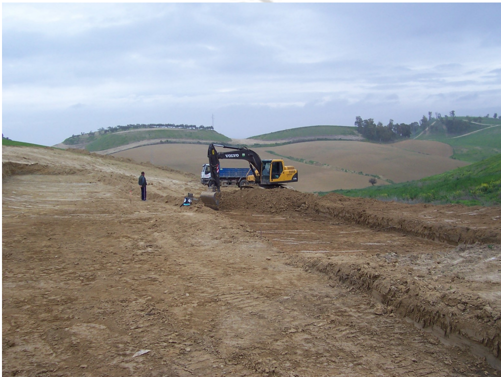
Figura 2. Comienzo de la excavación por tongadas
