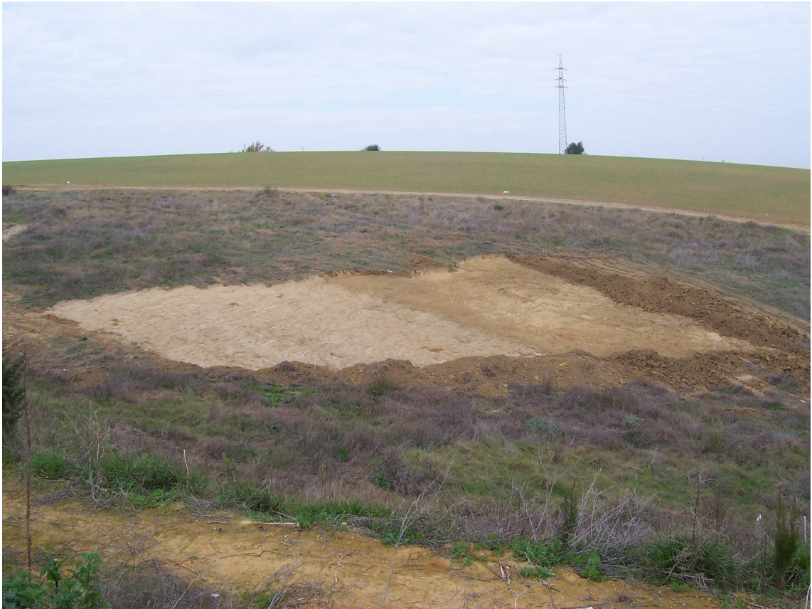
Figura 1. Desbroce de la parcela
