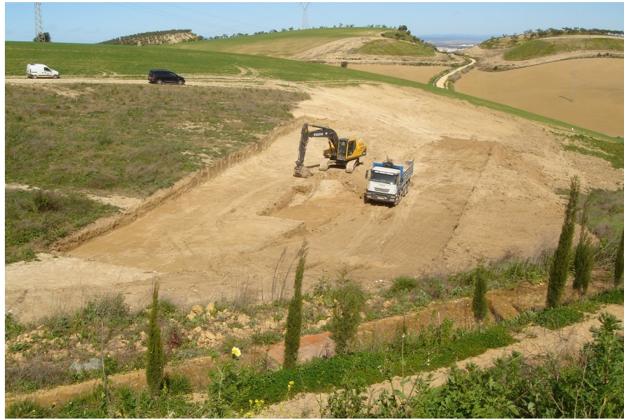
Figura 3. Vista general de la excavación
