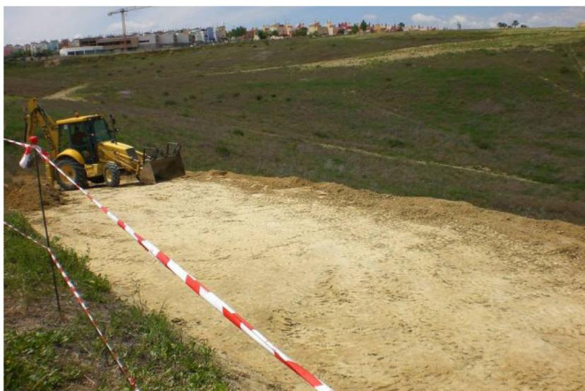
Lámina 1. Ejecución de la plataforma para acceso de maquinaria
