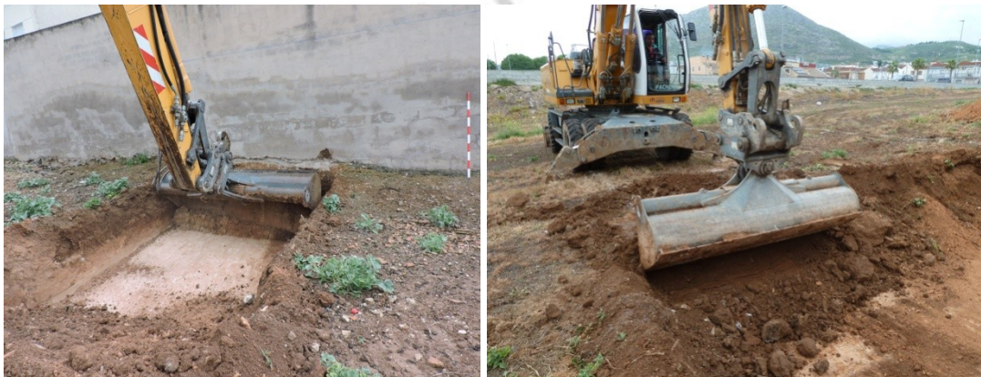
Lám. 2 y 3. Labores de desmonte de U.E 2. Tierra de cultivo
