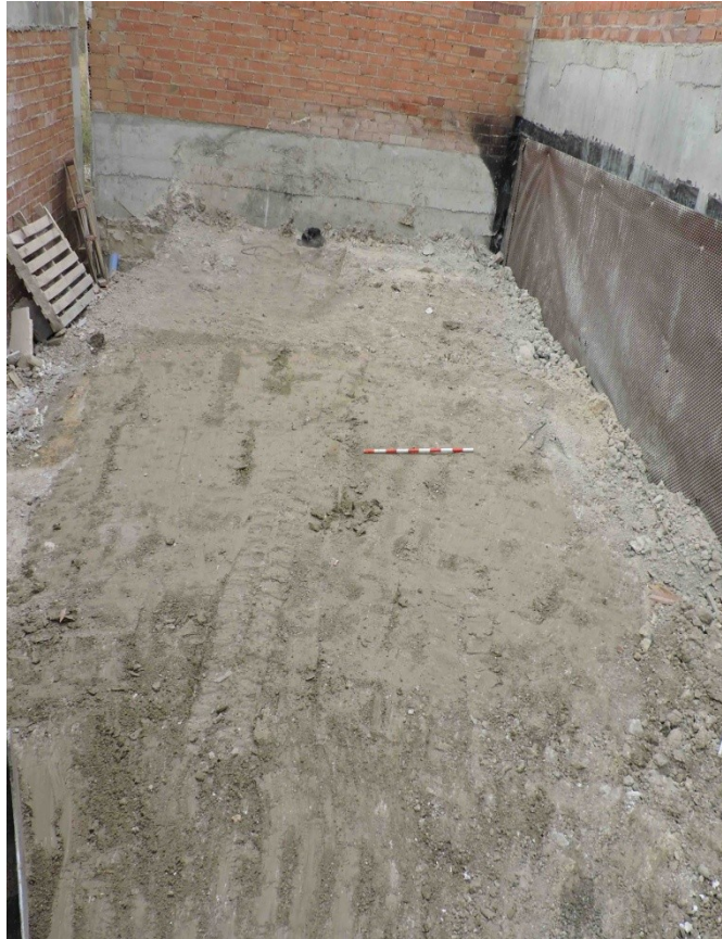
Lám 5: Vista final de la intervención
