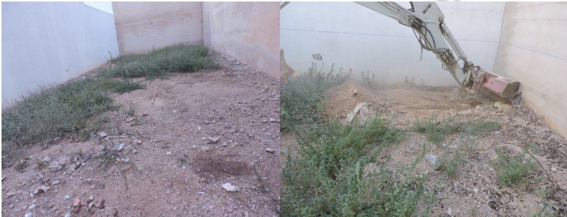
Lám 1 y 2: Vista previa e inicio de las labores de limpieza
