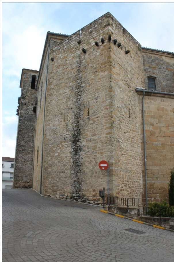
Lám. 3. Detalle de la torre esquinera suroeste.
