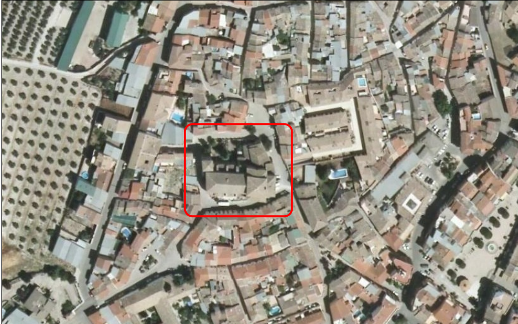
Fig. 1. Localización del inmueble en el casco urbano.
