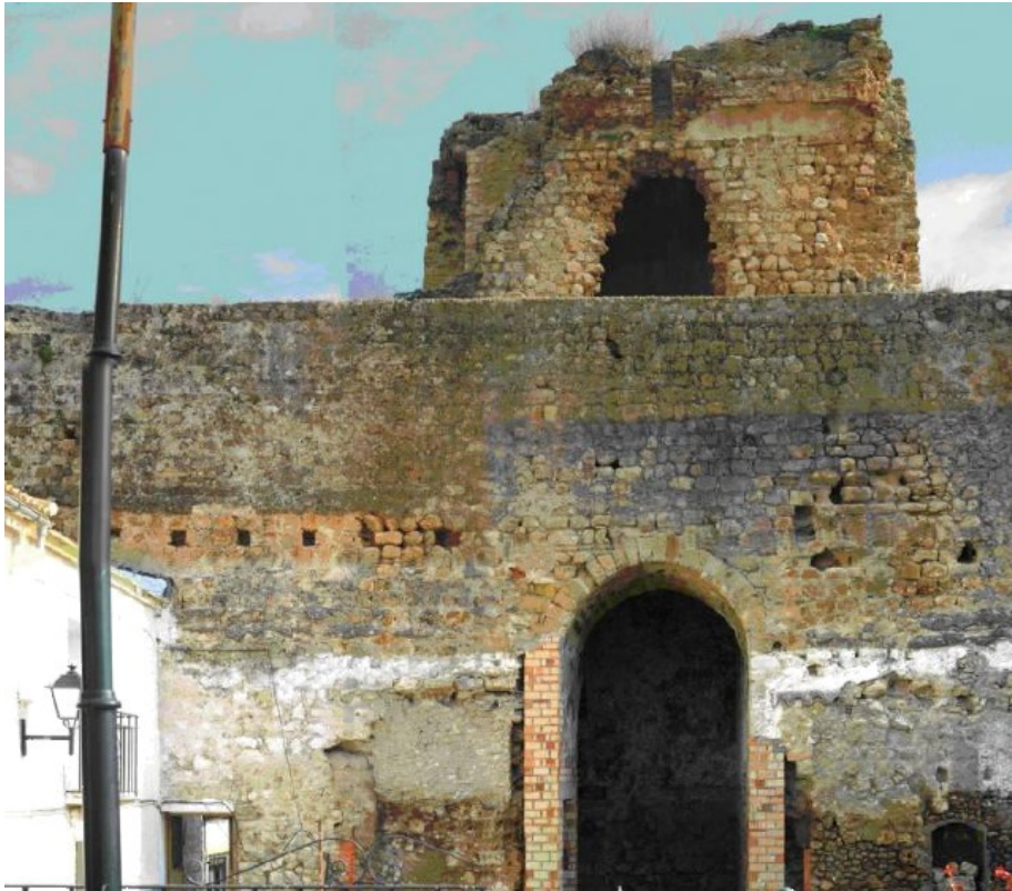
Lámina 04.- Sector – 4: Vista general desde el Patio de Armas del castillo de la cara interna del cierre meridional.
