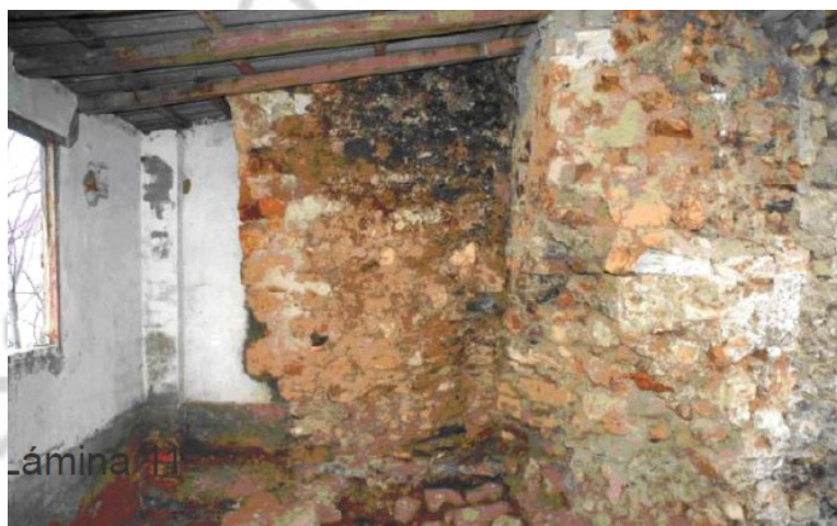
Lámina 11.- Sector-5: Vista de los Paramentos S, T y U y núcleo enripiado de la torre SE.
