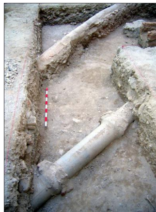
Foto: vista de las canalizaciones de fase contemporánea.
