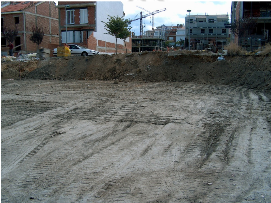
Fig. 2 Desarrollo de los trabajos.
