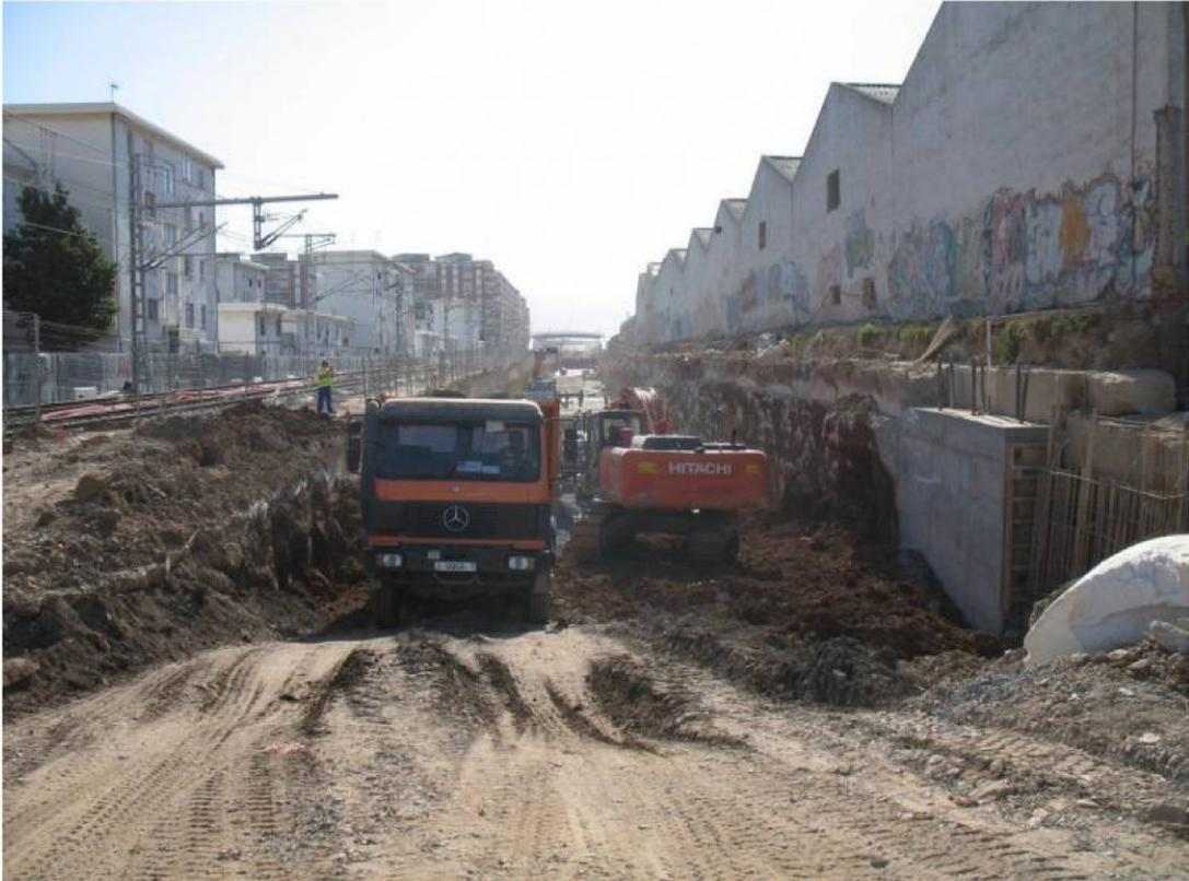
Figura 4: Polígono de Desplado de Arroyo Morales, Camino 2 (Caminos de Acceso a los túneles de Álora, Espartal, Tevilla, Gibralmora y Cártama (L.A.V. Córdoba – Málaga)Lámina 1: Excavación entre pantallas (L.A.V. Córdoba – Málaga, Tramo XXII, Integración del ferrocarril en Málaga)
