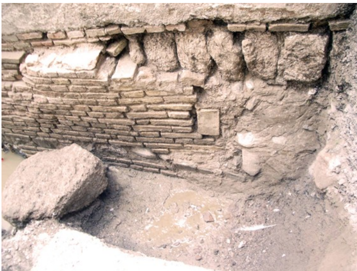
Figs. 12. Detalle del lienzo externo con sillares superpuestos a la zarpa de la muralla.
