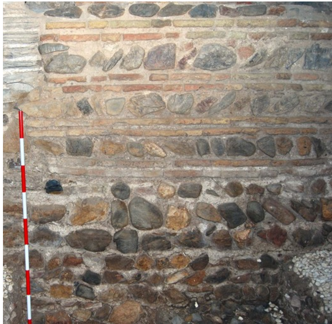
Figs. 15. Detalle del recrecimiento nasrí sobre la fábrica original.
