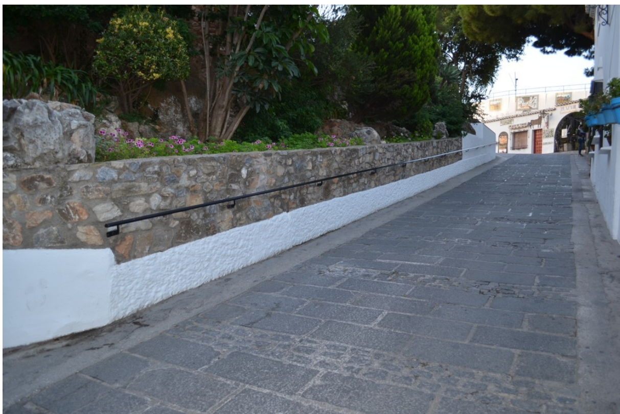
Lám. 1. Calle antes del inicio de las obras
