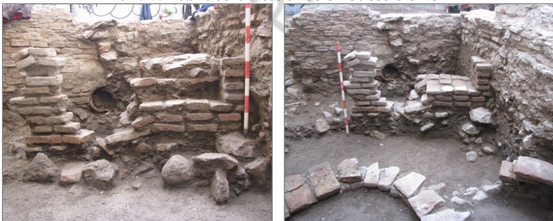
Láms. VI y VII: UE 37 con vano cegado y cegamiento desmontado
