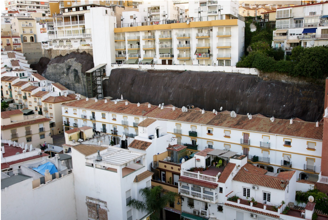
Lam. 2 Vista general talud con sistema contención ya finalizado.
