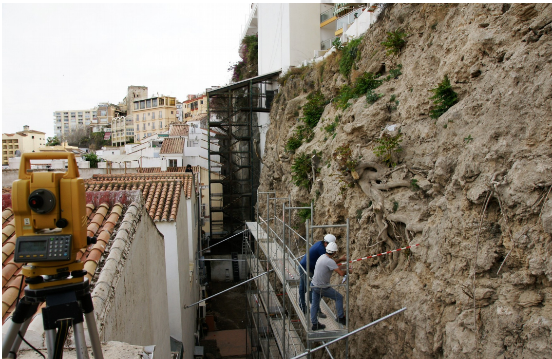
Lam. 1 desarrollo trabajos toma de puntos topográficos
