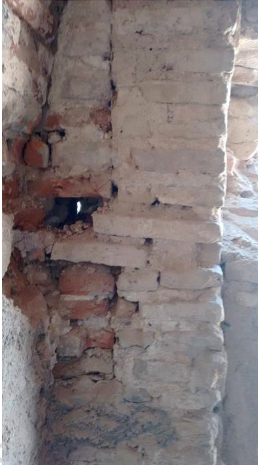
Figura 4. Contacto entre 21 y 5 desde la estancia 9, aquí se observa el adosamiento primero de la nueva mocheta 22 (fase2), y a esta en “L” el muro 5.
