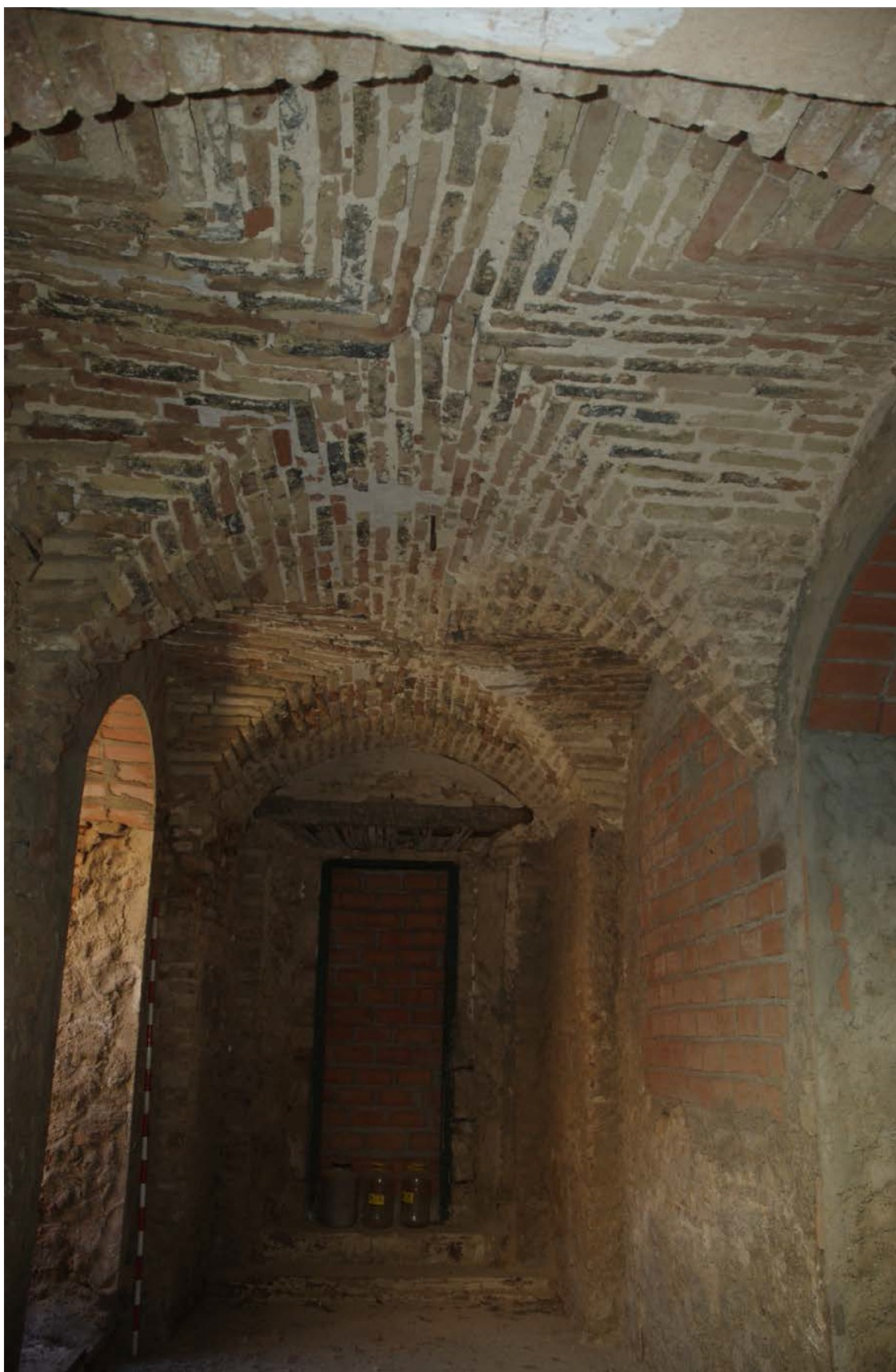
Figura 7. Estancia 9. Al fondo, puerta tapiada que comunicaba con el patio empedrado central.
