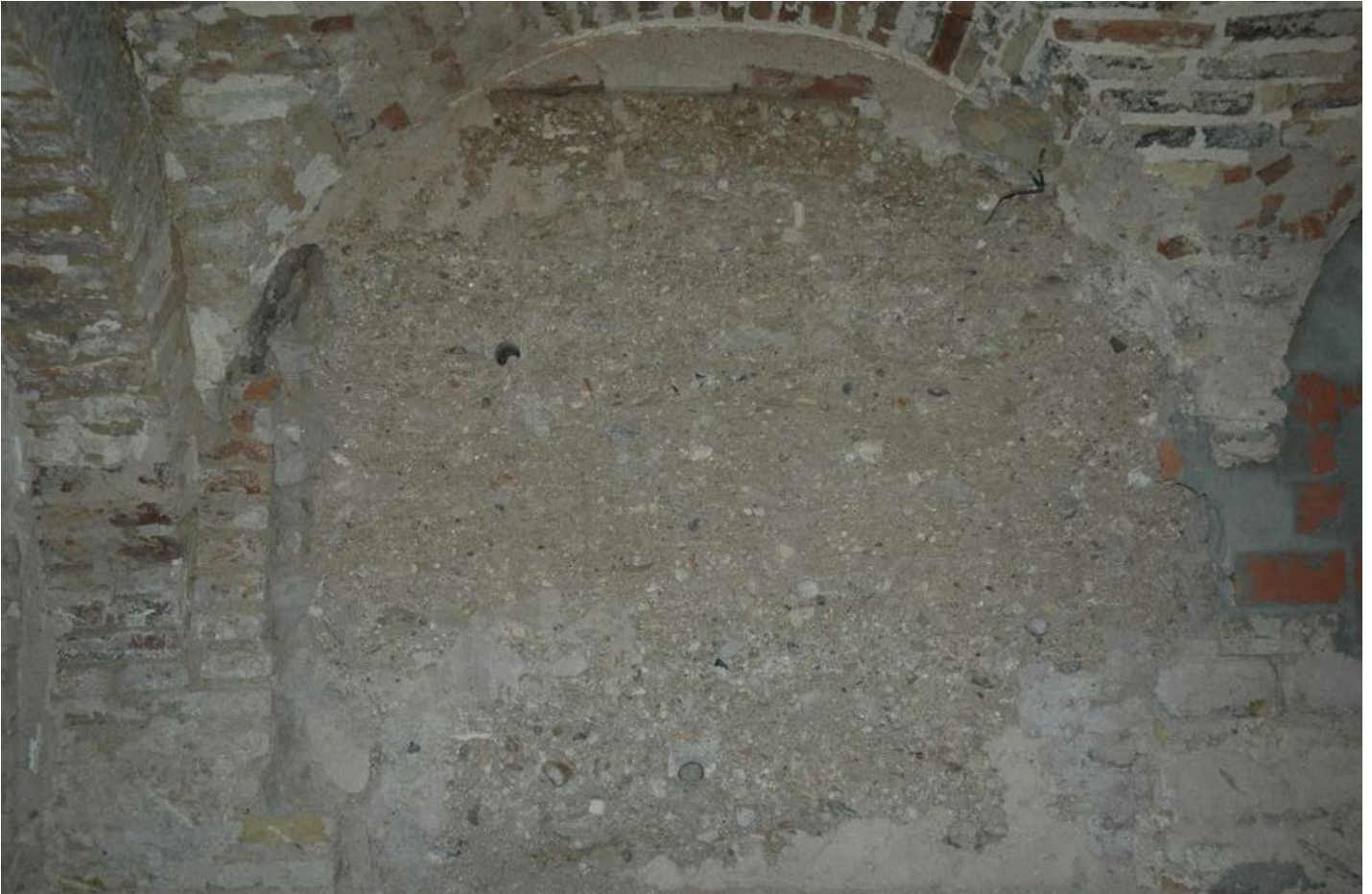
Figura 6. Imagen de la bóveda encajada en el tapial del muro 19.
