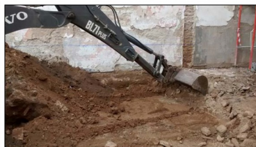
Rebaje en zona central del inmueble
