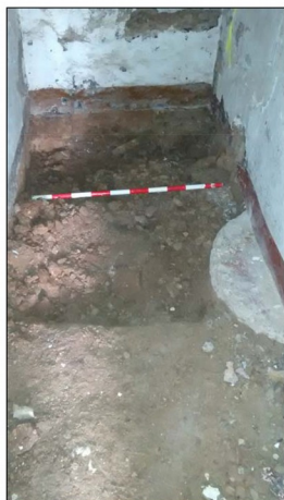
Rebaje en 1ª cruja (almacén)
