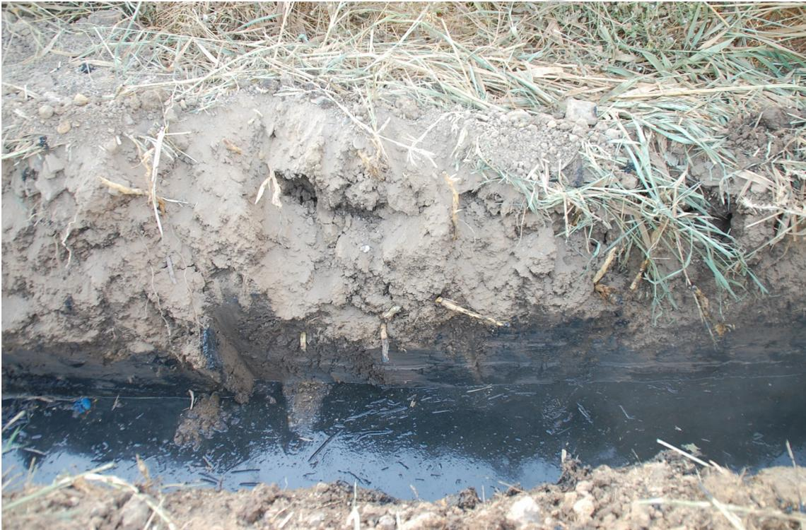
Lám. 2. Afección en profundidad de las raíces de la vegetación sobre el terreno en el que se abre la zanja. Bajo la superficie del agua aparecía la losa de hormigón usada como asiento.
