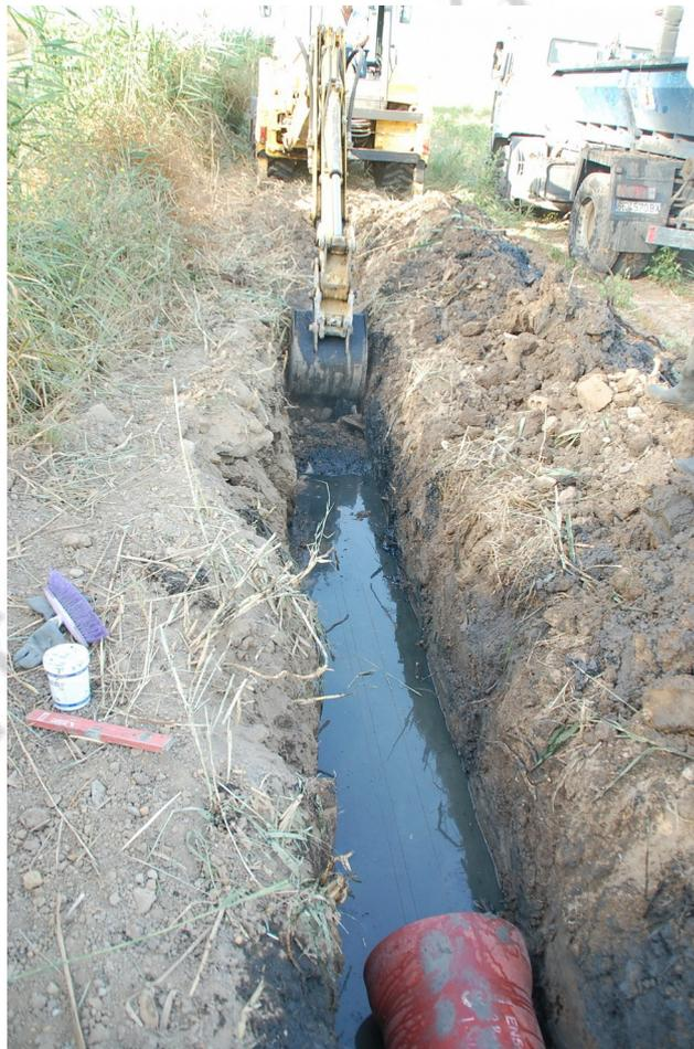
Lám. 1. Apertura de la zanja en el Tramo 1. Puede apreciarse parte del nuevo tubo de fundición de color rojo y la afección de la vegetación sobre los rellenos existentes.
