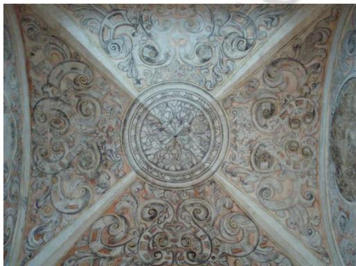
Reintegración de lagunas: para esta fase se empleó un mortero de cal de Lafarge y marmolina de granulometrías diferentes según el número de capas aplicadas. El aglomerante utilizado es hidráulico y no aporta sales al conjunto. Para evitar las sales se empleó aguas desmineralizada en todos los procesos.
