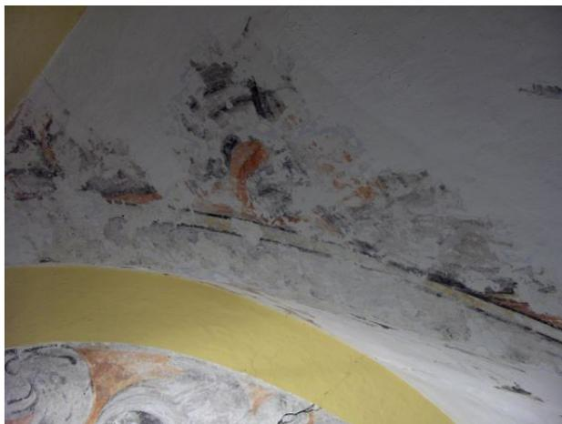
Limpieza: eliminación de capas de cal mediante métodos mecánicos, empleando bisturí y, en zonas puntuales, un torno pequeño con una broca de piedra pómez. Los repintes de barniz fueron retirados empleando acetona pura y con la ayuda del bisturí también.
