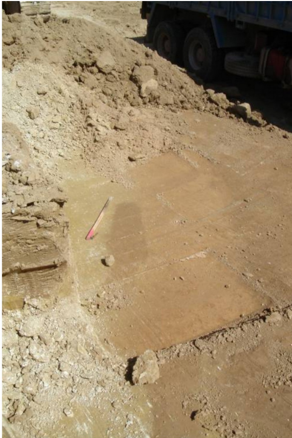
Lám.4. Zona de diferente coloración por oxidación natural de las arcillas
