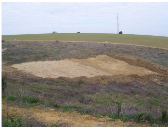
Lám. 1. Desbroce de la parcela
