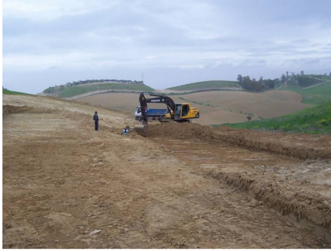
Lám.2. Comienzo de la excavación por tongadas
