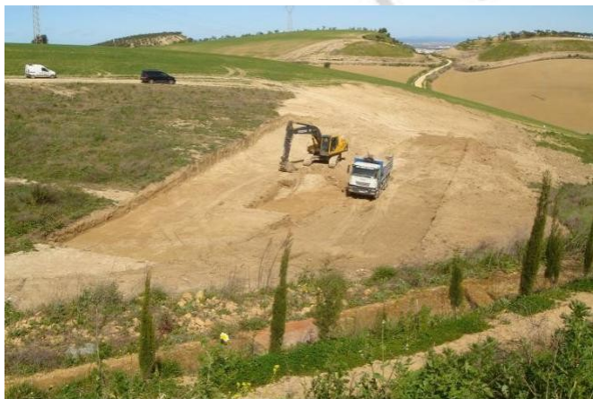
Lám.3. Vista general de la excavación
