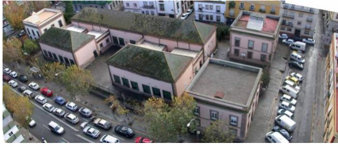
Figura 1. Vista aérea desde el noroeste del C.E.I.P. Altos Colegios Macarena.
