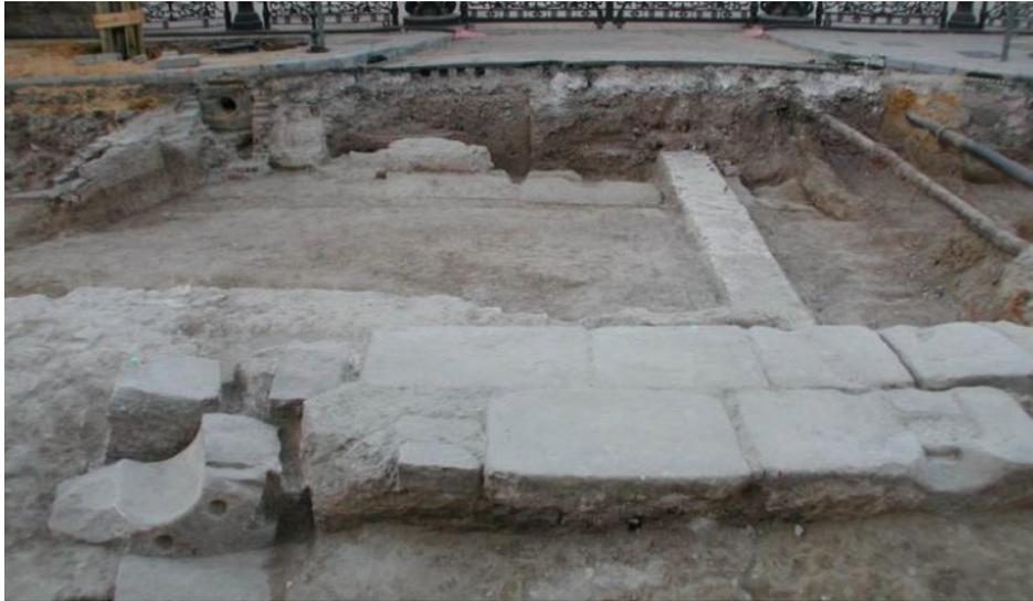
Fig. 21: Sector G. Losas de Tarifa situadas en el vano de la puerta de la Fábrica de Tabacos y sillares de granito para anclaje de las columnas de hierro de la verja, posteriormente retranqueada a la posición que hoy ocupa (al fondo)
