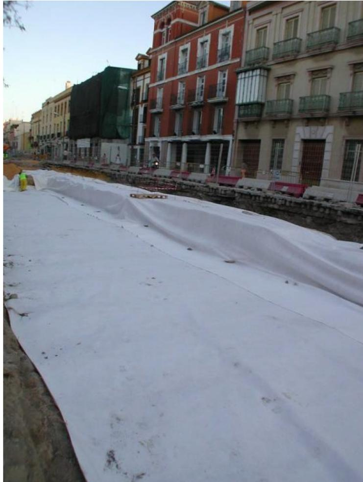
Fig. 23: Sector G. Cubrición de los restos con malla geotextil
