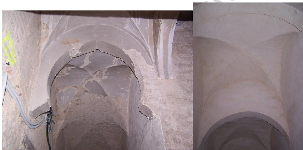
Figura 5. Estado de las bóvedas de la escalera antes y después de su rehabilitación.
