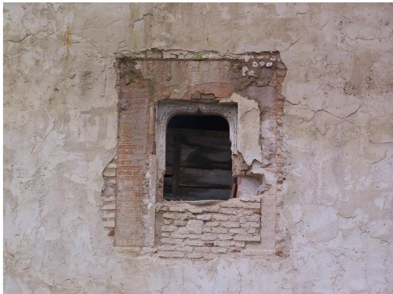
Figura 4. Ventana con arco conopial en el que se observan las dos fases de su construcción: una primera con jambas de ladrillo en limpio y una segunda en la que se reduce el hueco y se realiza el arco conopial.
