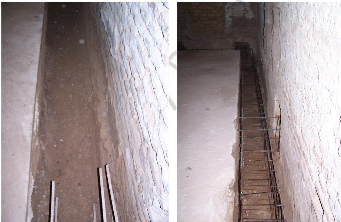
Figura 1. Zanjás de cimentación con la anchura y profundidad máximas alcanzadas donde se observa la zapata de cimentación del muro y la armadura de la cimentación.
