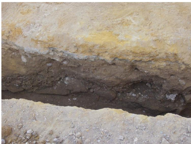
Figura 6. Detalle del perfil resultante de la excavación de la zanja para acometida de agua.
