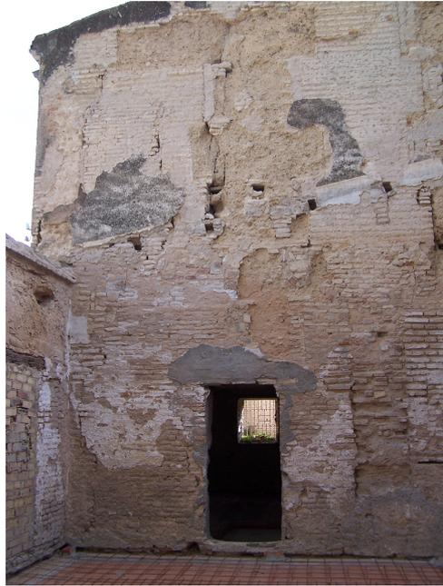
Figura 10. Paramento en el que se observan las reformas y reparaciones tras el terremoto de 1504.
