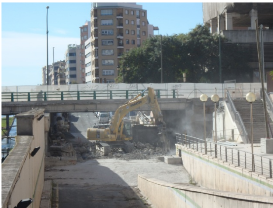
Lám. 3 – Demolición del Estribo 1 del Puente de Tetuán
