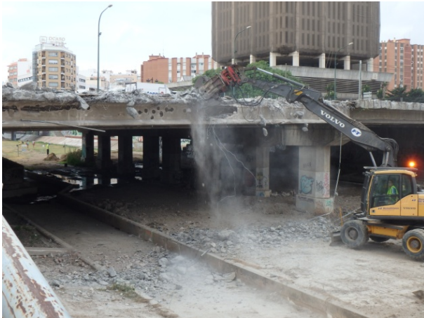
Lám. 2 – Demolición del tablero norte del Puente de Tetuán
