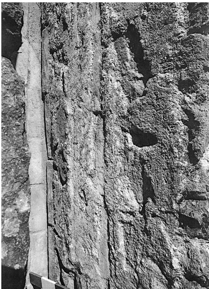
*Lámina II.* Improntas de los tabloneros del encofrado en el revoco del canal.
