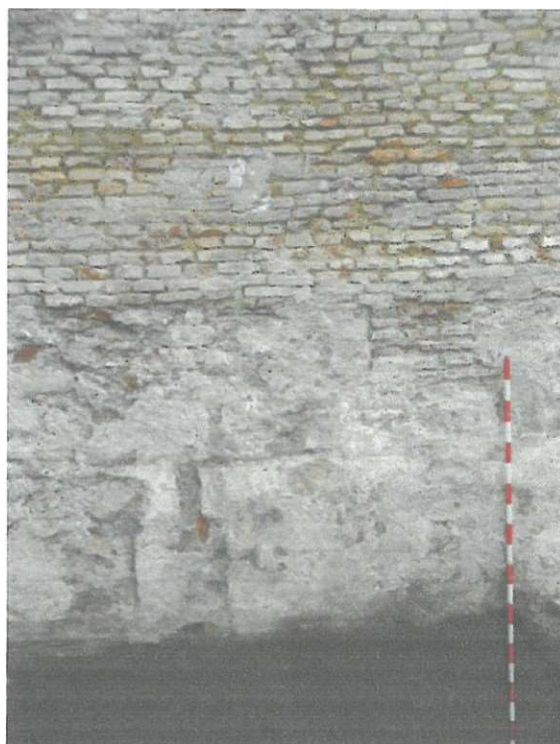
Fig. 3: En la Z-I. U.E.C. 10 fábrica original del Acueducto de San Telmo que constituye su alzado inferior, formada por cantos, ladrillos en hilera, ripios y matacanes. Potencia: 2,27m.
