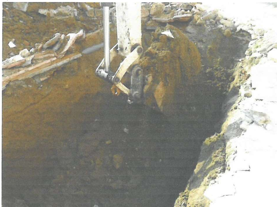
Fig. 3: En la Z-I. U.E.C. 10 fábrica original del Acueducto de San Telmo que constituye su alzado inferior, formada por cantos, ladrillos en hilera, ripios y matacanes. Potencia: 2,27m.
