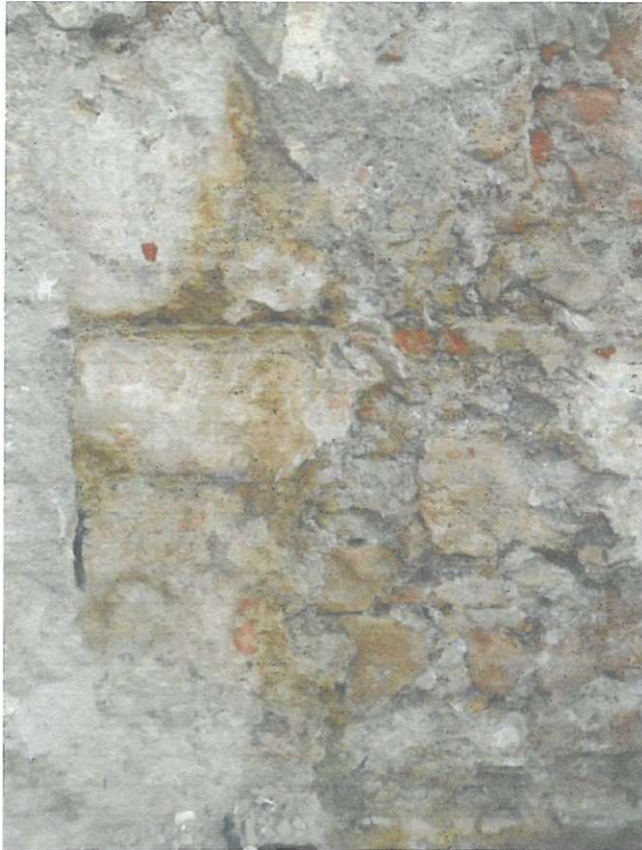
Fig.1: En ambas zonas, restos del enfoscado original del acueducto U.E.C. 06 cubriendo al mortero del propio acueducto U.E.C. 07.
