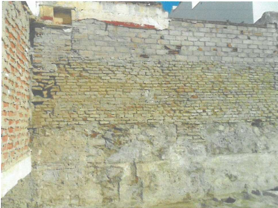
Fig.1: En ambas zonas, restos del enfoscado original del acueducto U.E.C. 06 cubriendo al mortero del propio acueducto U.E.C. 07.
