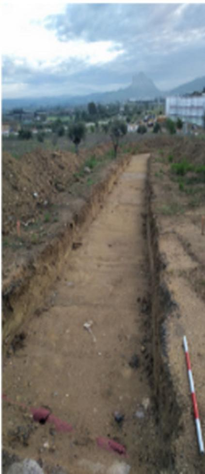
En este aspecto se han realizado actuaciones para añadir un acceso peatonal al Oeste: Para ello se excava una zanja de 2'30 metros de ancho desde la valla que separa las obras del recinto de los Dólmenes hasta la entrada occidental del edificio. Con una potencia de 40-50 cms, la excavación muestra dos estratos distintos: desde superficie una capa de tierra vegetal (U.E.1) de escasa potencia cubriendo un estrato de tierra marrón con ligero componente arcilloso y pequeños nódulos de cal (U.E.2).
