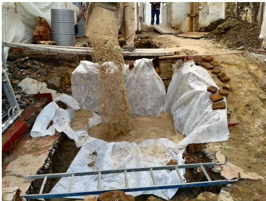
FIGURA 16. PROCESO DE RELLENADO DEL HORNO CON ARENA SOBRE GEOTEXTIL
