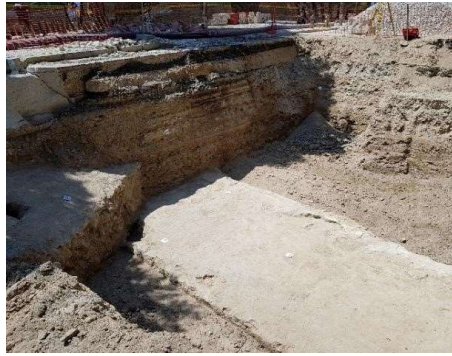
Lámina 1.- Localización el colector cruzando el muro oeste del Fuerte de San Lorenzo.
