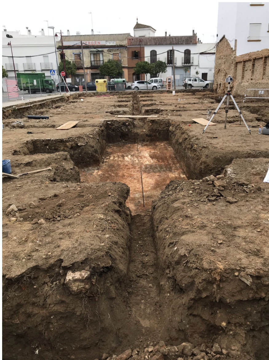
Lámina VII. Vista general de la parcela una vez ejecutados los bataches y zunchos de cimentación.
