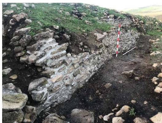
**Figura 15.** Yacimiento de Ategua. Área de intervención Sector 2. A la izquierda, Torre 3 con su paramento este y pie amigo retacados con mortero. A la derecha, trabajos ejecutados en el lienzo de muralla junto a la Torre 3.
