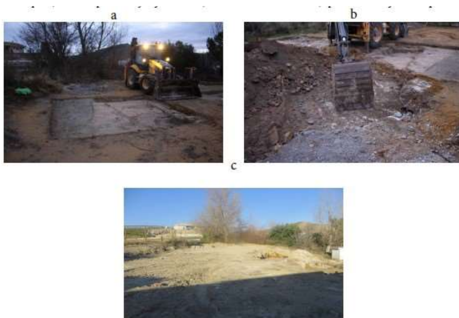
Fig. 8: control de los movimientos de tierra: a) inicio de los trabajos; b) detalle del nivel geológico a pocos cm de la superficie; c) vista general de la parcela tras la retirada del sedimento.
