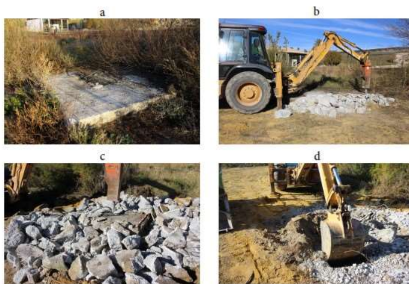
Fig. 6: Sondeo 3: a) losa de hormigón sobre el emplazamiento del sondeo; b) empleo de maquinaria pesada para la eliminación de la losa; c) detalle de los trabajos; d) retirada del escombros.
