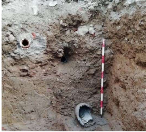
Zanja del servicio sustituido
