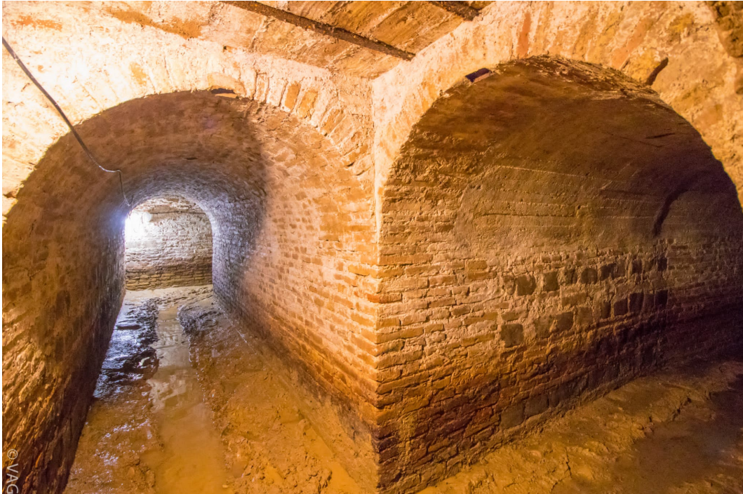
Lám. II.- Vista del cruce de los dos tramos del refugio antiaéreo de la Plaza Vieja.
