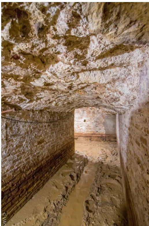
Lám. VIII.- Tramo del subsótano o refugio antiaéreo que aprovecha la cimentación del antiguo castillo como techo.
