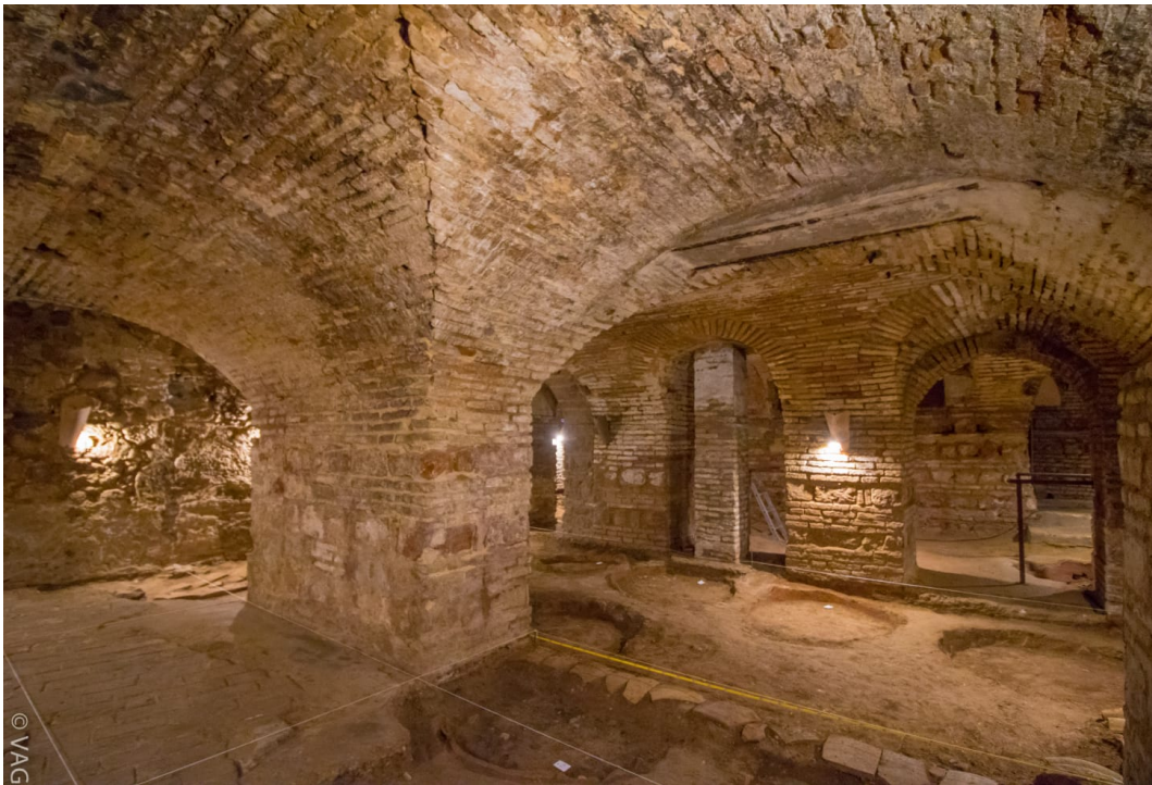
Lám. III.- Vista general de la sala 2 de los sótanos del castillo.
