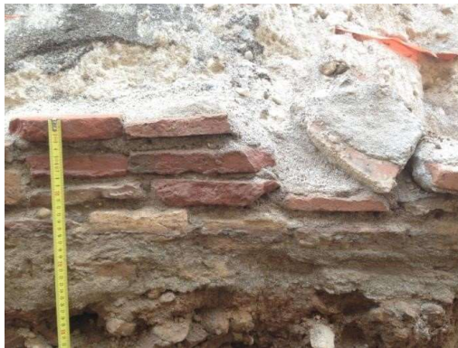
Lám. 5 Imagen en detalle de la canalización 03 a la altura del portal nº1
