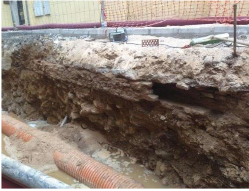
Lám. 6 Vista general de la canalización 03 entre los nº 1 y 3
