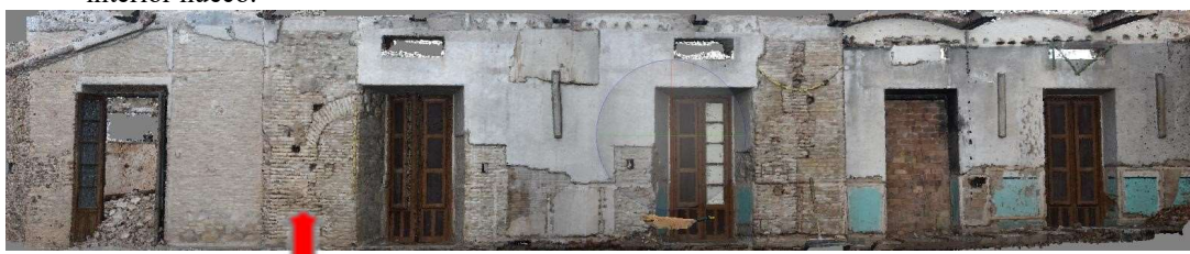
Lamina 11 -Panorámica de la primera planta, una vez demolidas las fábricas interiores.
