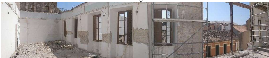
Lamina 8 -Panorámica de la segunda planta, una vez demolidas las fábricas interiores.
