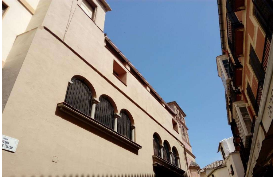
Lamina 3 Fachada del inmueble previo a la actuación.
