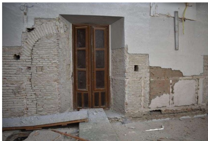
Lamina 12 -Detalle del lienzo con arcada del edificio original.
