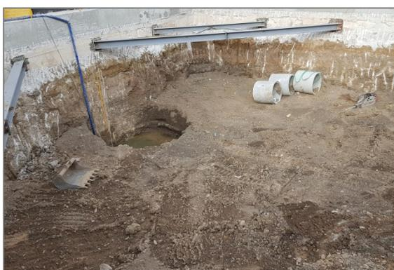
Rebaje y excavación del pozo para la instalación de la bomba.
