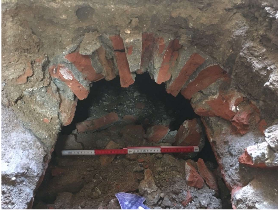
Fig. 3: Embovedado de ladrillo del antiguo sistema de alcantarillado en el sector 2C.
