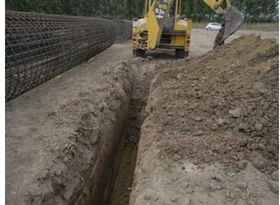
Sondeo 1 eje pilotes Estribo 2 E-29
