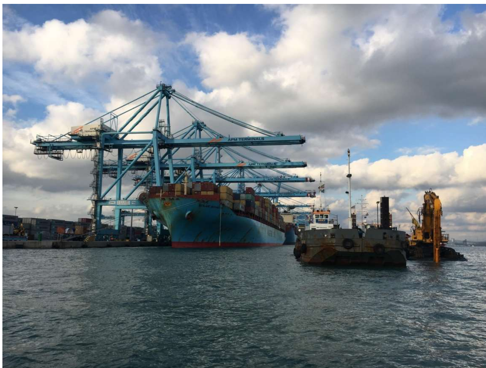
Lámina I: vista de la zona de dragado con los equipos trabajando
