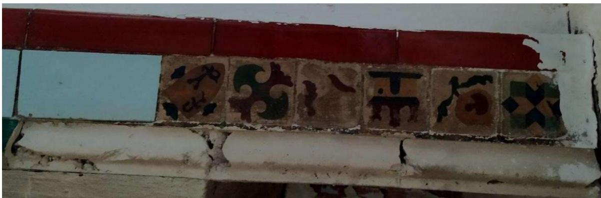
**Ilustración 19:** *Olambrillas de suelo hidráulico decorando una chimenea.*
