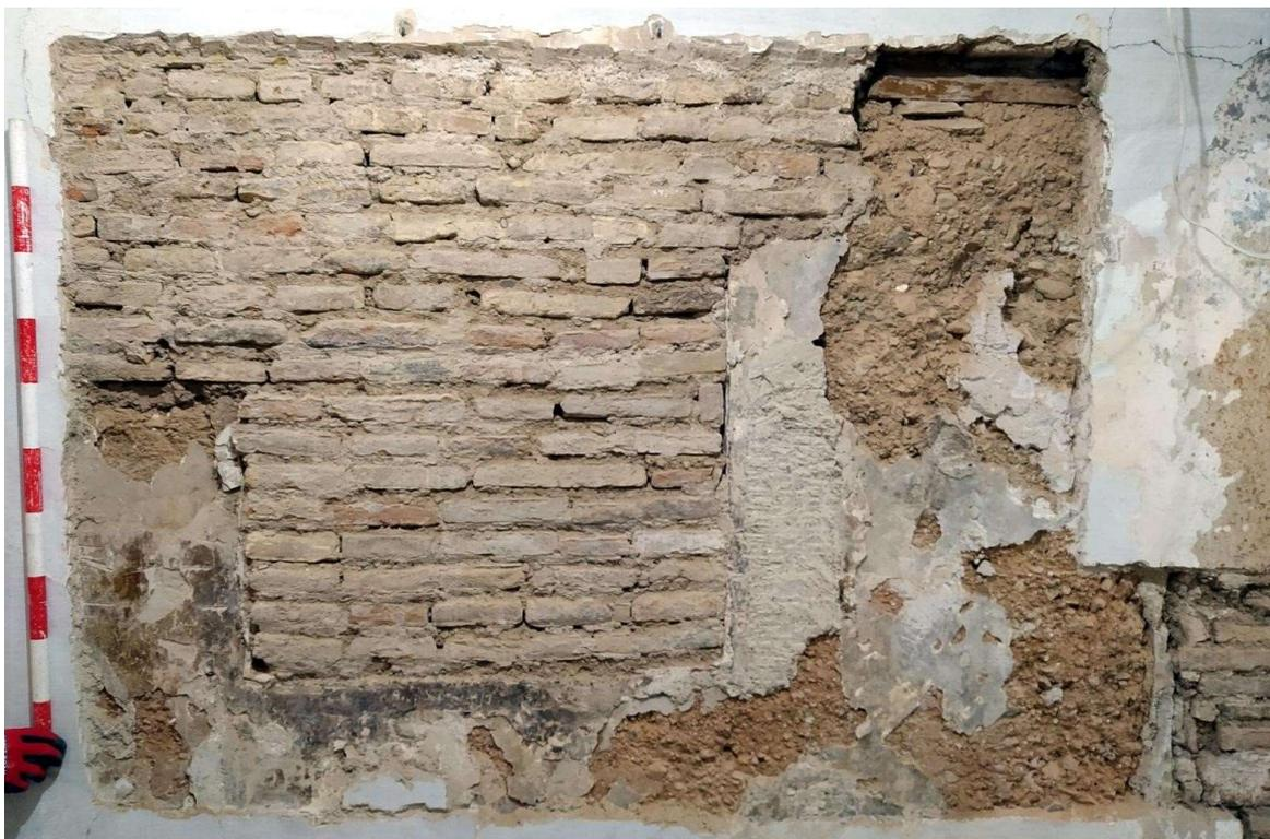
**Ilustración 5:** *Cata muraria 20, con un hueco cegado con ladrillo en el muro de tapial.*
