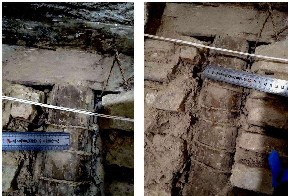
**Ilustración 16:** Pilares de madera con ataduras de esparto para adherir al muro de ladrillo.
