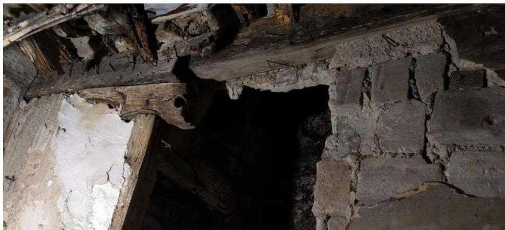
**Ilustración 18:** *Zapata desarticulada por la construcción de una chimenea*
