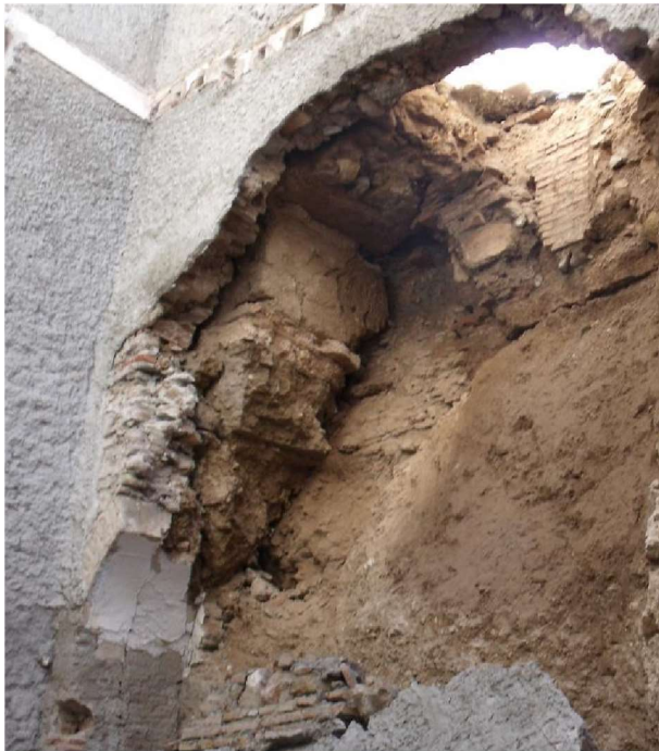
IMAGEN Del derrumbe de la cerca en medina conde donde se observa en sección el esquema de mantenimiento
