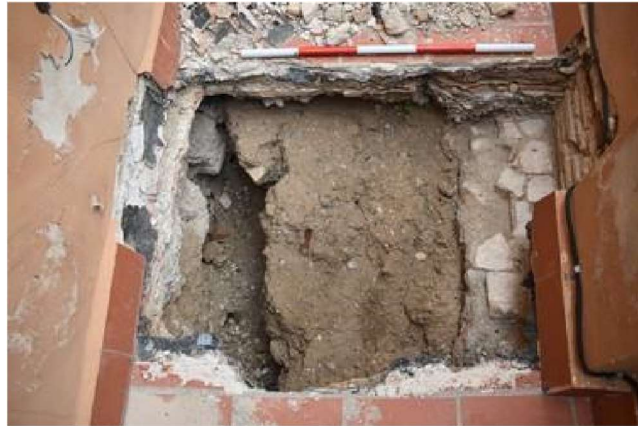
IMAGENES DEL SONDEO CON LA FABRICA DE TAPIAL EN PARTE CENTRAL DESDE DISTINTAS VISTAS.
