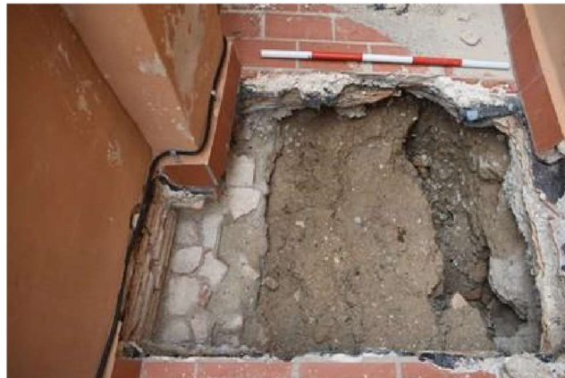
IMAGENES DEL SONDEO CON LA FABRICA DE TAPIAL EN PARTE CENTRAL DESDE DISTINTAS VISTAS.
