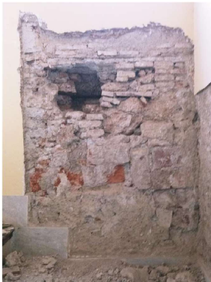
IMAGEN DE LA CATA 4 CON LOS TAPIADOS Uu. ee. 3, 4 y 5
