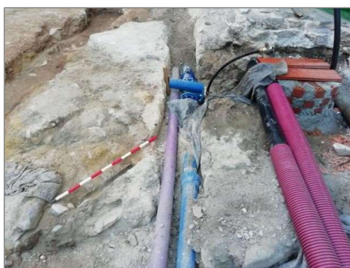
Instalación del servicio de baldeo (morado) y agua potable (azul), aprovechando la zanja preexistente del gas.
