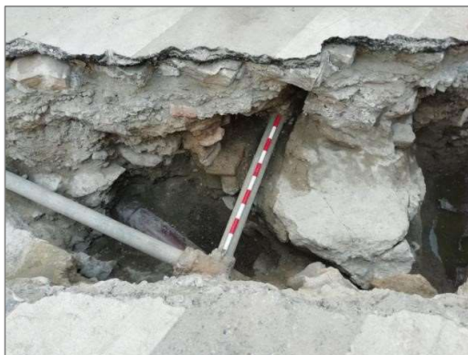
Estructuras arqueológicas y afecciones de los servicios a sustituir.
