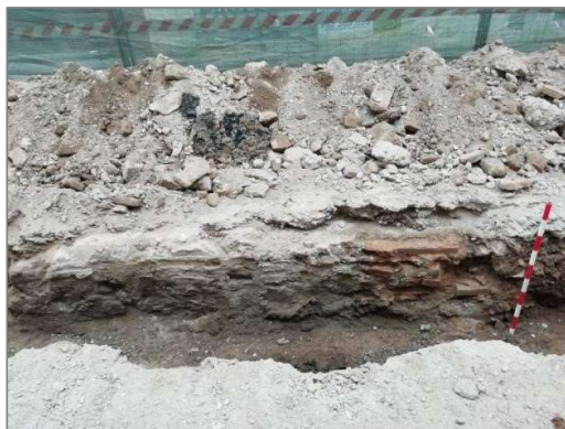
Estructuras localizadas en los perfiles de la zanja de saneamiento.
