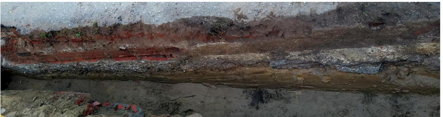
**Ilustración 11:** *Desagüe paralelo a la zanja, bajo el asfalto de C/ Cañaverál*
