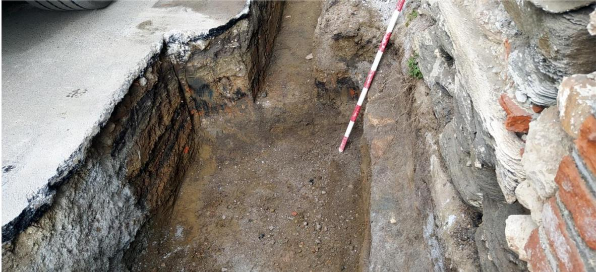
**Ilustración 12:** *Arqueta; cimentación; zanja con arena y doble capa de asfalto de C/ Cañaverál.*
