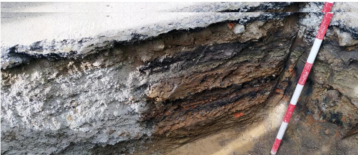
**Ilustración 9:** *Diferentes capas de asfalto cortadas por una zanja rellena de arena.*
