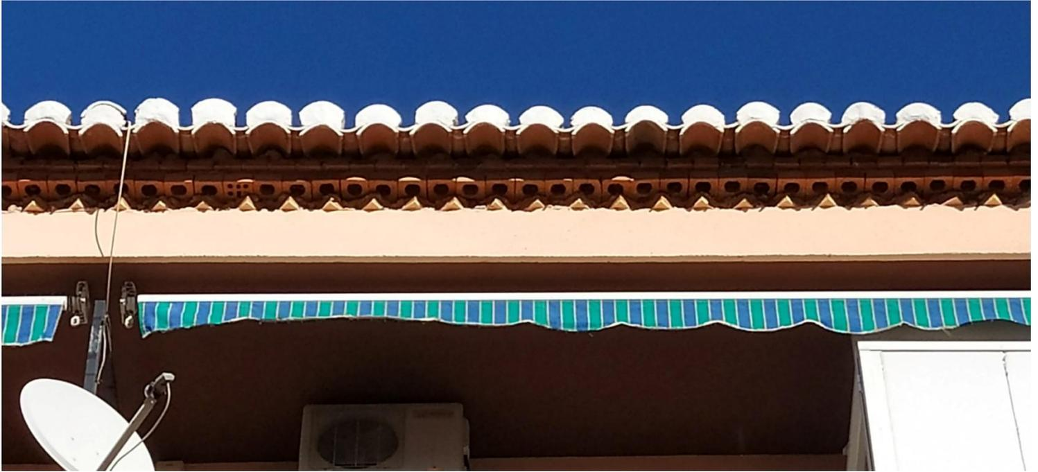
**Ilustración 4:** *Ladrillo macizo con hueco circular. Alero del tejado del Edificio Corregidor, nº 27.*
