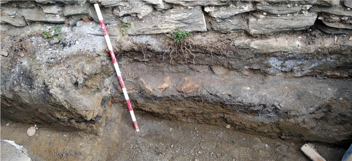
**Ilustración 8:** *Cimentación de piedra, de micaesquistos, sobre la tierra limo arcillosa.*
