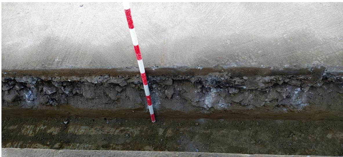
**Ilustración 15:** *Diferentes acometidas interceptadas por la zanja.*
