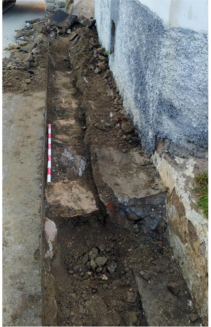
**Ilustración 10:** *Desagüe amortizado bajo el asfalto de C/ Cañaverál. Paredes de hormigón.*
