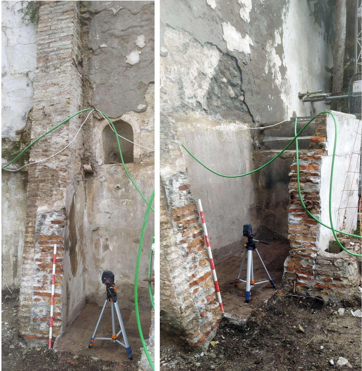
Ilustración 8: hornacina, tuberías y Aljibe integrado en uno de los contrafuertes del muro
