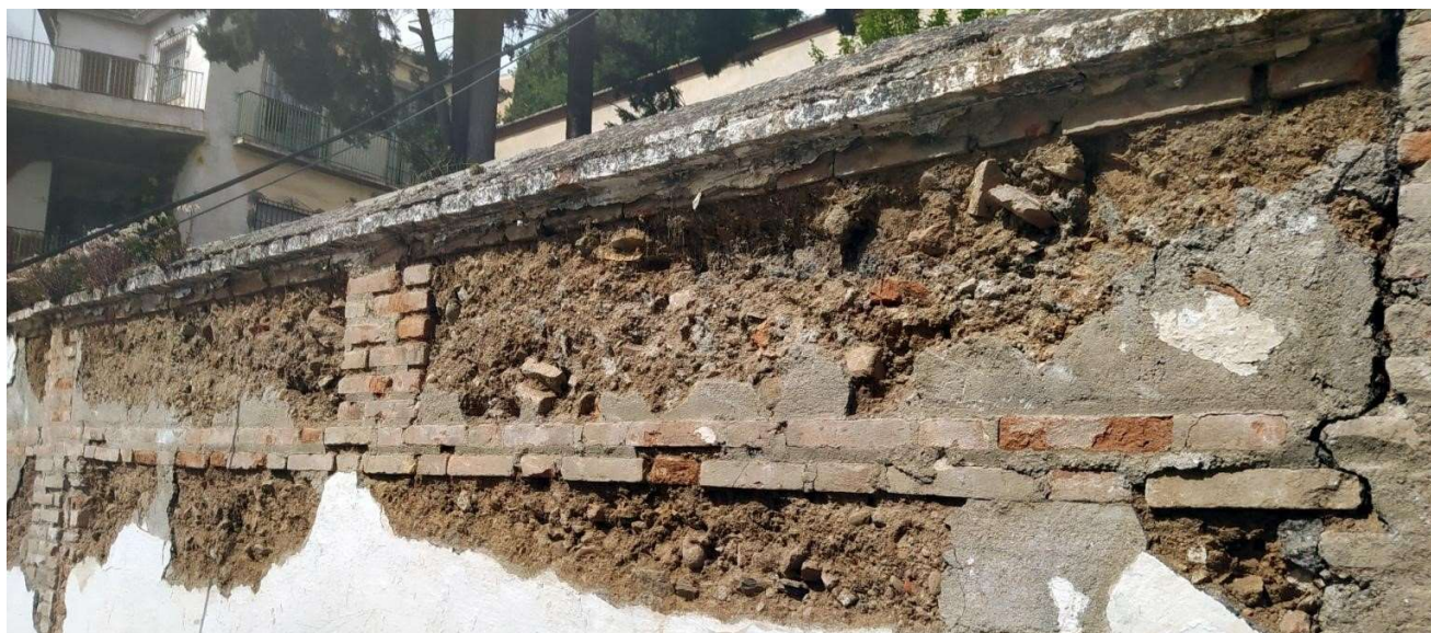
Ilustración 10: Muro de la terraza inferior, también de tapial con verdugada de ladrillo.
