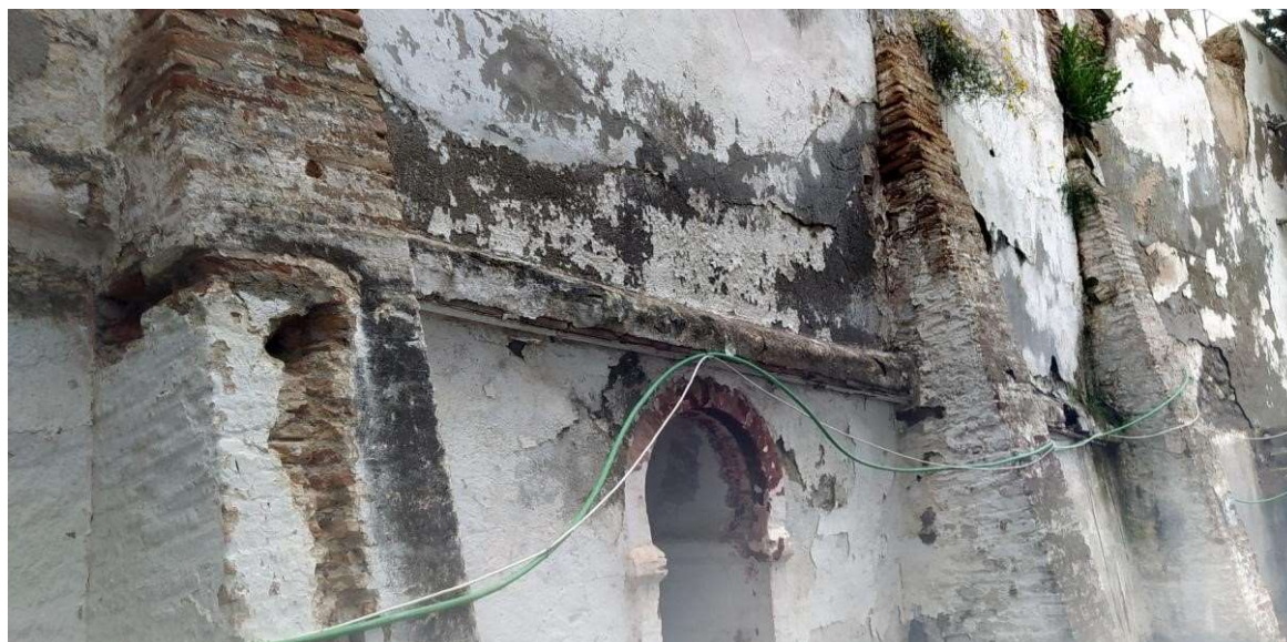
Ilustración 5: Muro con contrafuertes; canalización de atadores y entrada a una cueva.
