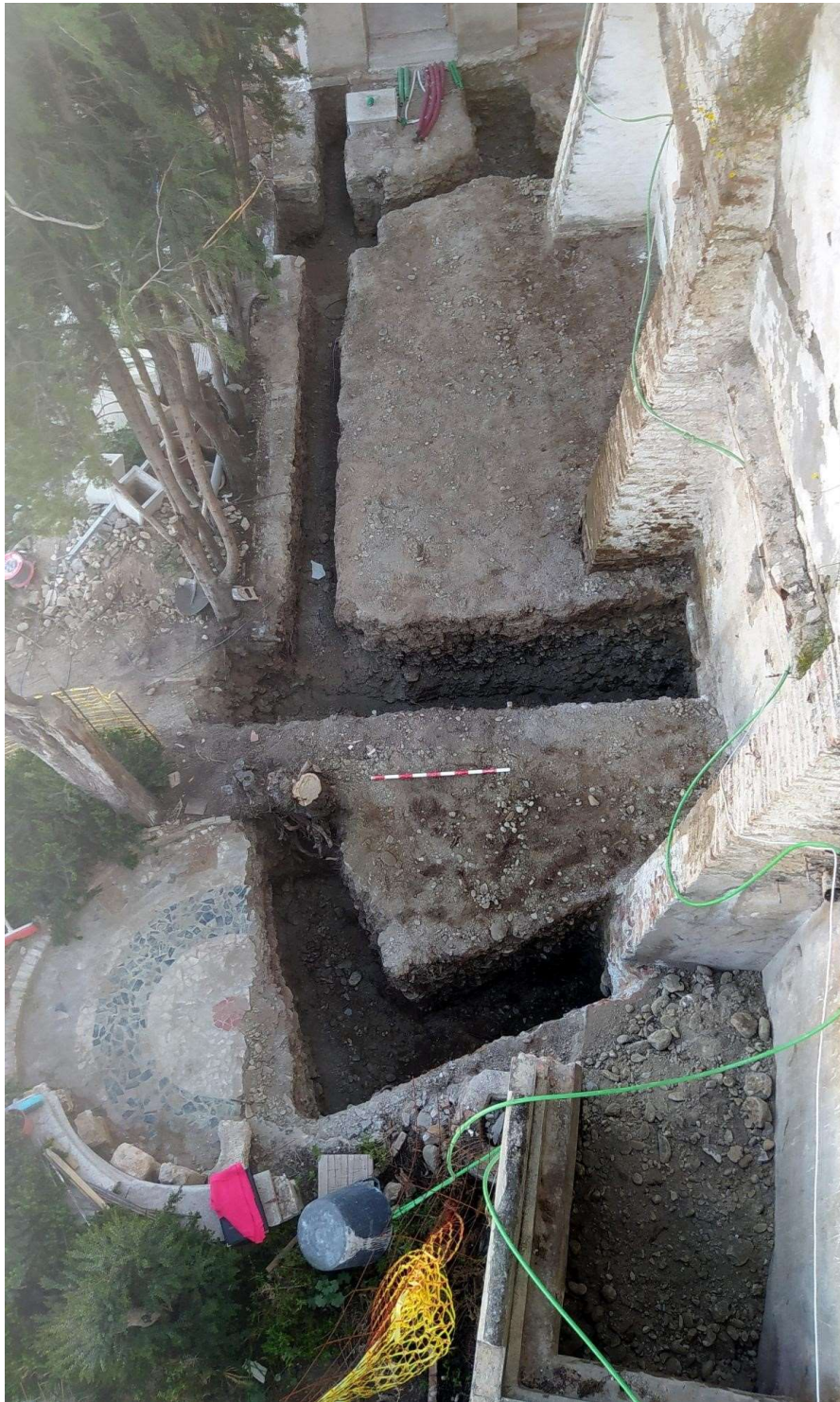
Ilustración 21: Las Zanjas una vez abiertas.
