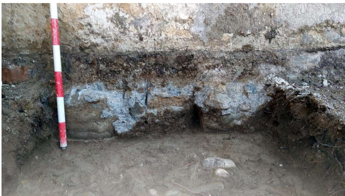
Ilustración 20: Cimentación del muro con contrafuertes, E-6, sobre la zahorra del terreno.
