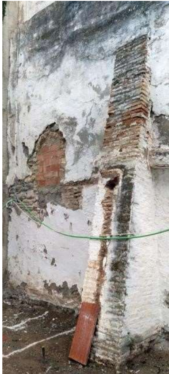
Ilustración 14: Uno de los tres contrafuertes del muro de aterrazamiento.
