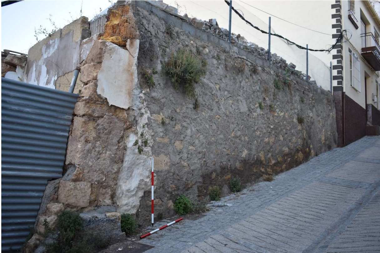
Figura 3. previo intervención en calle Pintor 15 Dirección Noreste.
