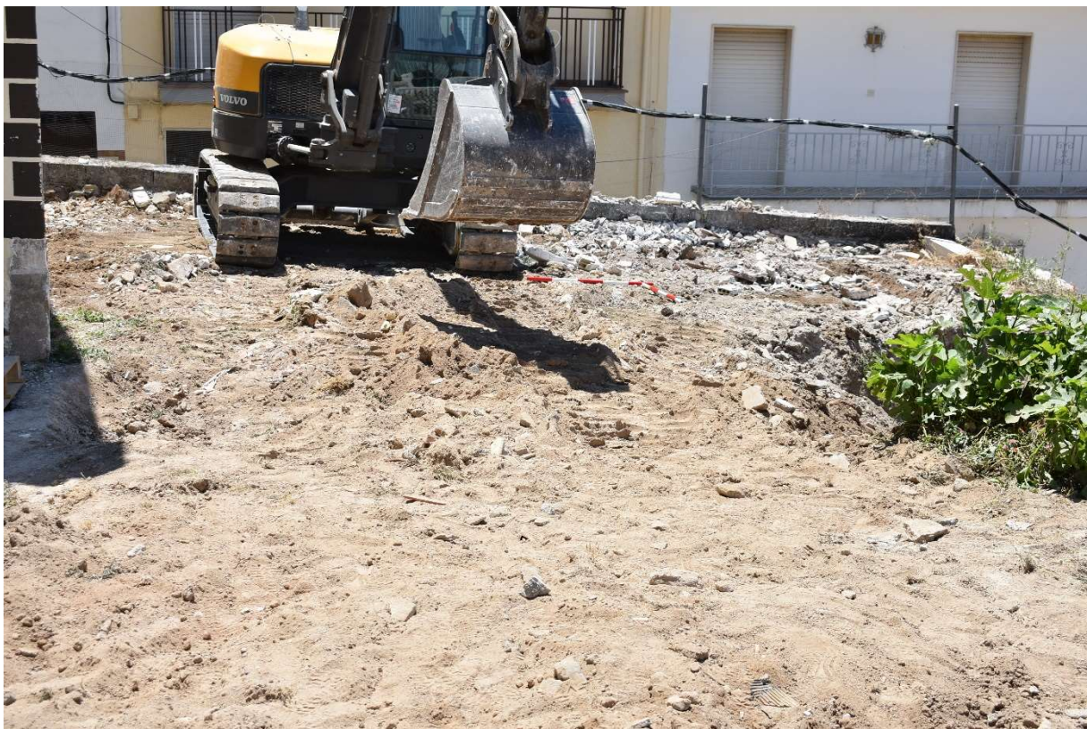
Figura 4. Zona suroeste del solar tras la retirada de los escombros.
