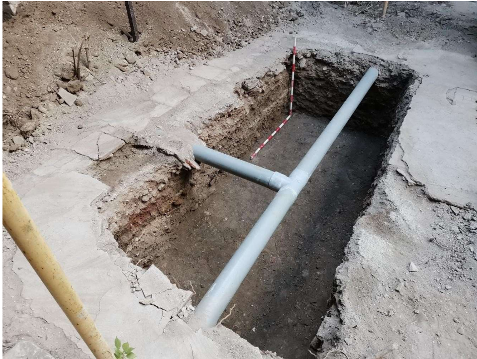
Lámina 4. Vista final del Sondeo S-4
