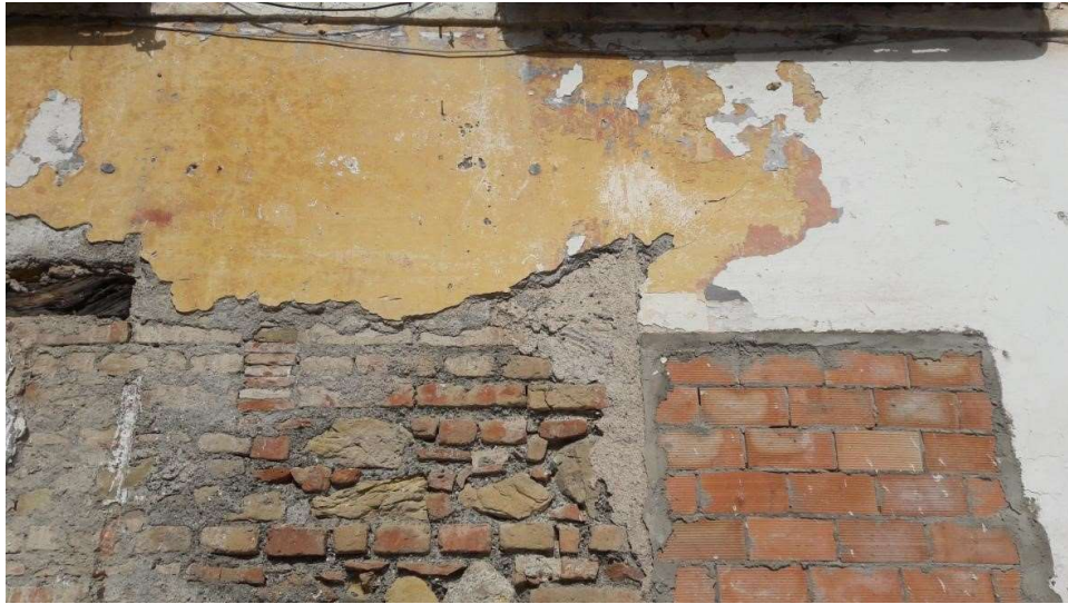
Lámina 18. Vista de la fábrica de la fachada en la planta baja
