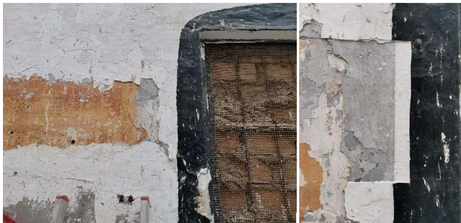
Láminas 11 y 12. Proceso de limpieza de la Cata C-2
