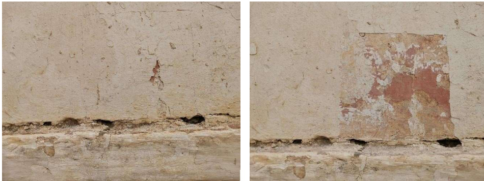
Láminas 14 y 15. Proceso de limpieza de la Cata C-6
