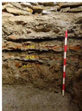
Fig. 4. Vista del perfil oeste del sondeo. Se aprecia la sucesión de pavimentos en 50 centímetros, usando la misma técnica: capa de grava de nivelación (UUEE 111 y 108), capa de mortero de fijación (UUEE 110 y 107) y solería. El pavimento de cantos (UE 112) está colocado sobre un estrato arcilloso (UE 113). La solería actual (UE 101) se sitúa sobre un nivel de relleno (UUEE 102, 103 y 104) nivelado por una capa de grava (UE 105)
