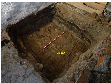
Fig.1. Vista del pavimento de cantos y ladrillos. (UE 112). Primer pavimento de la edificación, año 1900.
