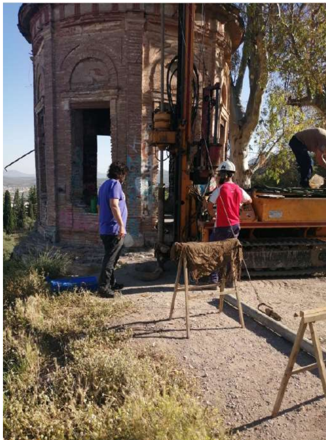
Figura 3.- Imagen de los trabajos en marcha con la máquina penetrando el lugar elegido para realizar el sondeo
